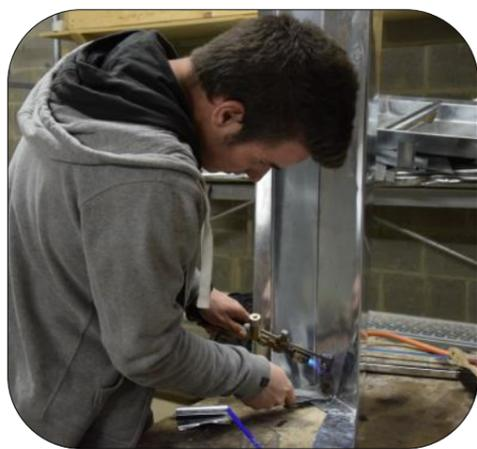
Soudure et façonnage de zinc
