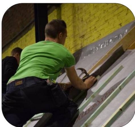
Pose de sous toiture et contre lattage
