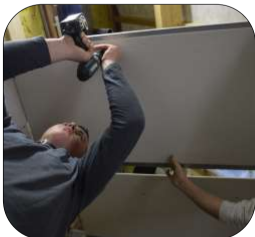
Pose de faux-plafond
