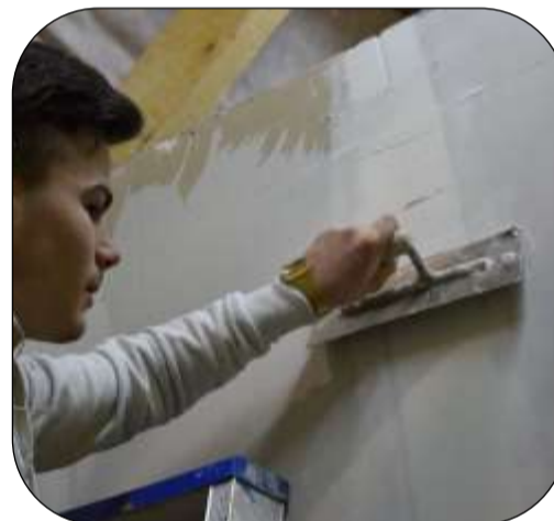
Enduisage à la plâtresse
