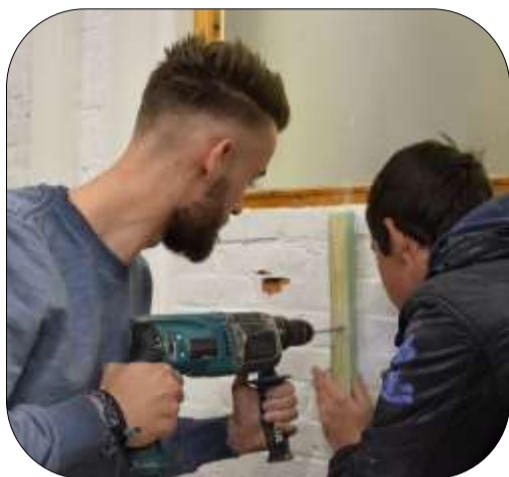
Préparation du chantier
