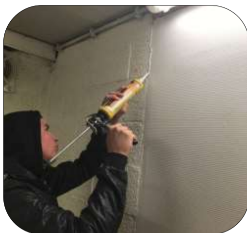
Pose de joint à la pompe
