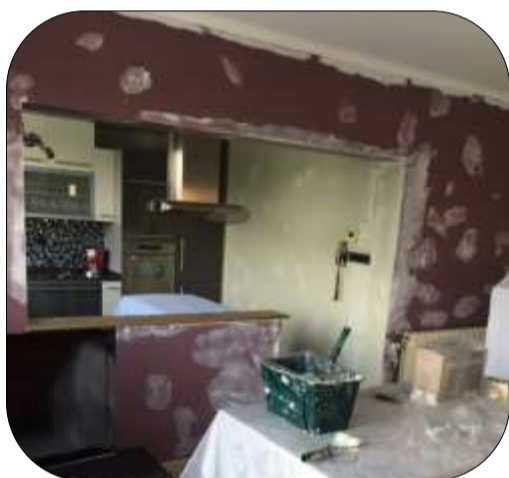
Chantier en cours (enduisage)
