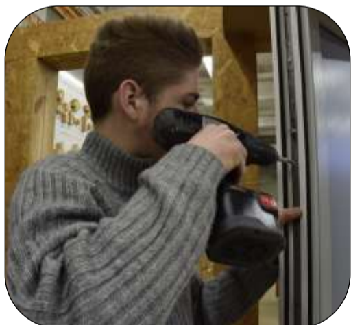
Pose de quincailleries
