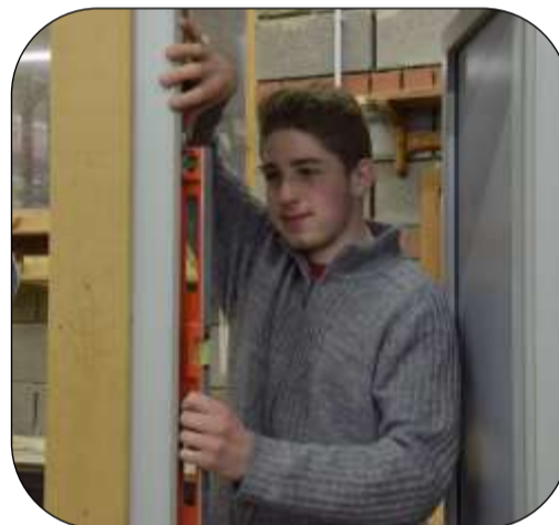
Pose d'un châssis
