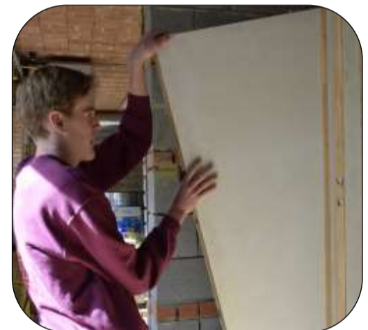
Préparation pose d'une porte
