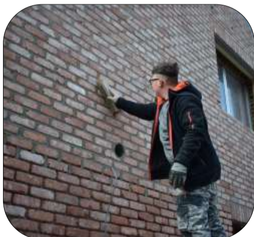
Brossage des joints
