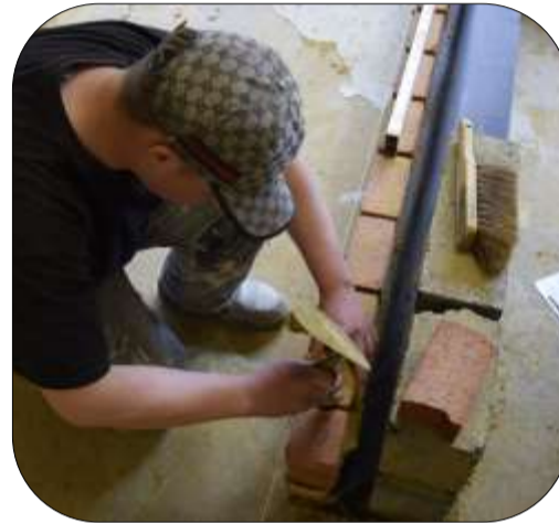
Mur creux en élévation
