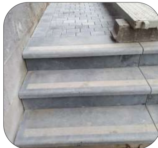
Pose de pierres bleues
