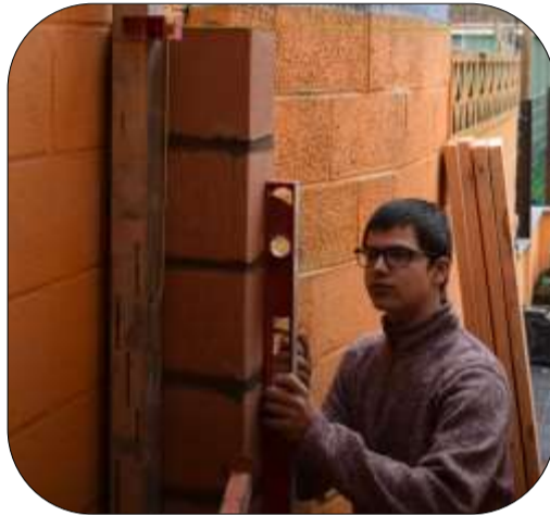
Vérification de la verticalité
