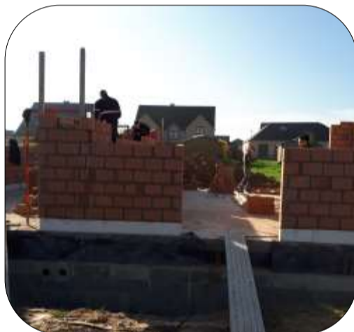
Construction de murs
