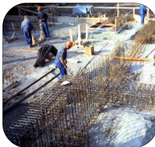
Assemblage sur place
