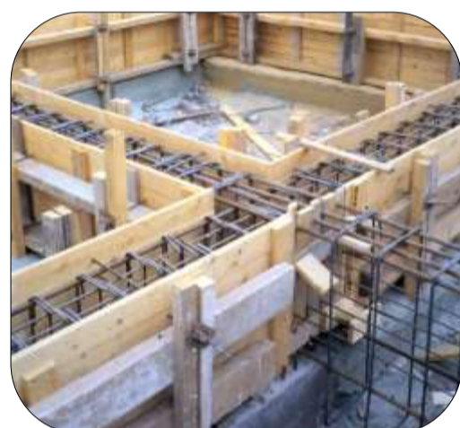
Coffrage et ferrailage ceinture
