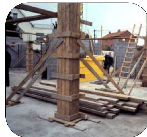
Coffrage d'une colonne
