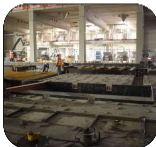
Pose de calles avant pose treillis
