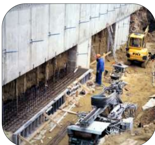
Chantier en cours
