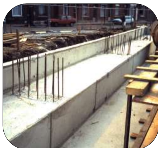
Ceinture avant coffrage de colonnes
