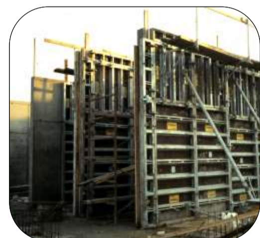
Coffrage de voiles (murs en béton)
