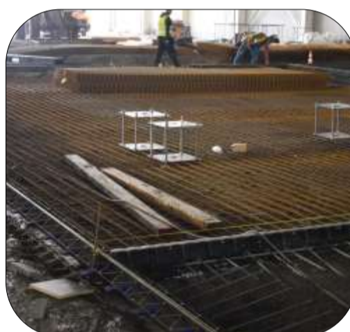
Pose de treillis en cours
