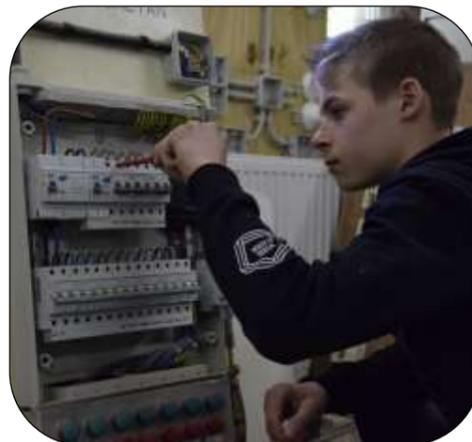
Raccordement d'un coffret
