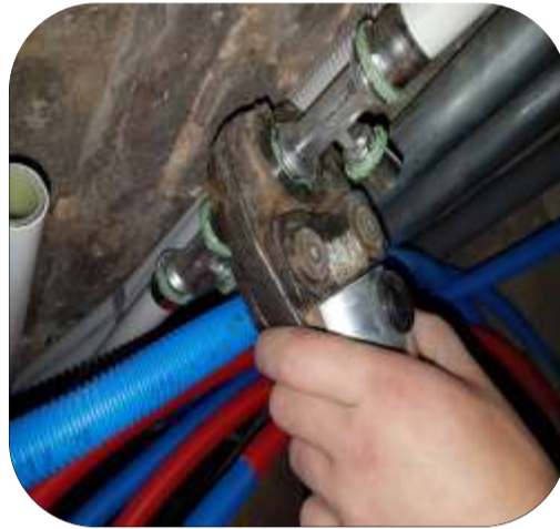
Sertissage de tuyauteries
