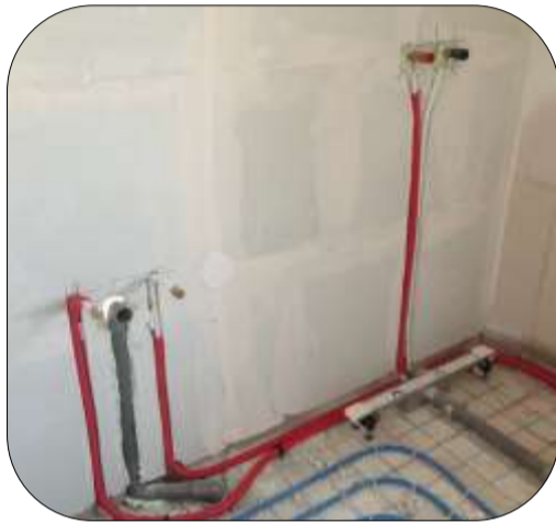
Encastrement des tuyauteries
