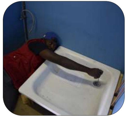
Fixation d'une crépine
