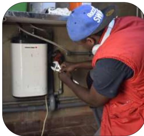
Installation d'un chauffe-eau
